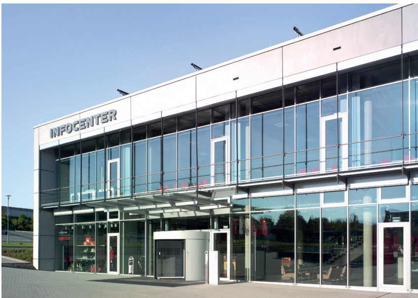
Immer auf dem neuesten Stand – in der Viessmann Akademie werden umfassende Schulungen zu unseren innovativen Energiesystemen angeboten.
